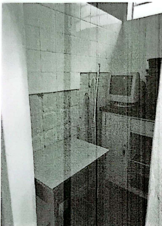
Foto 6: Depósito (parte inferior) – revestimentos (aluzejos) necessitando manutenção.
