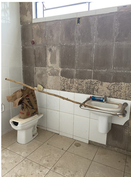
Foto 01: revestimento cerâmico e peças sanitárias nos sanitários – situação atual
