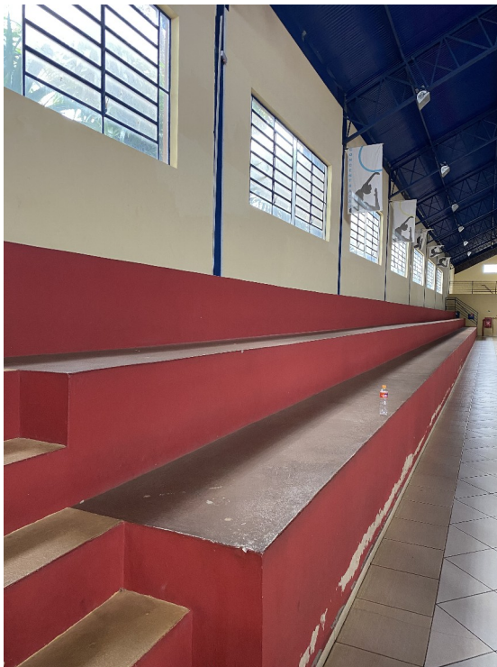
Foto 06: Pintura interna a ser executada.
